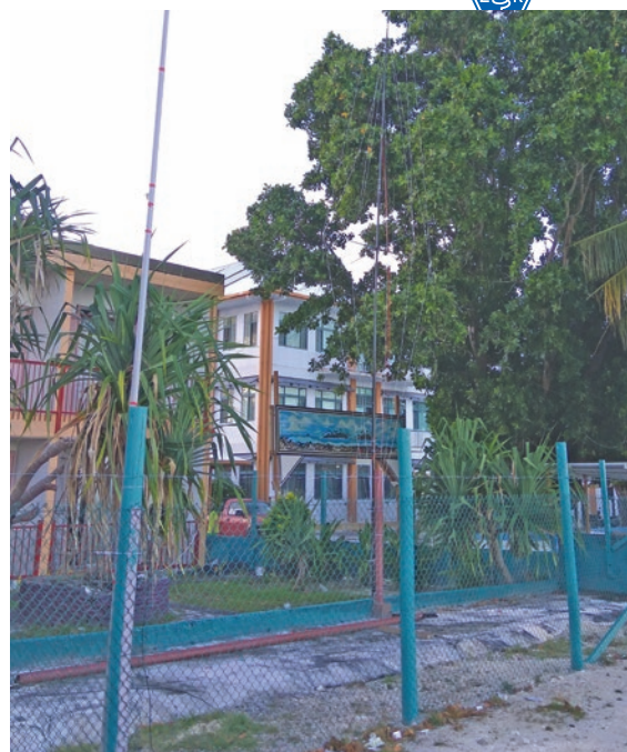
ANTENY – GP 40 M (NA PIERWSZYM PLANIE) I MASZT DLA DIPOLI PIONOWYCH Z LINKAMI USZTYWIAJĄCYMI KONSTRUKCJĘ
