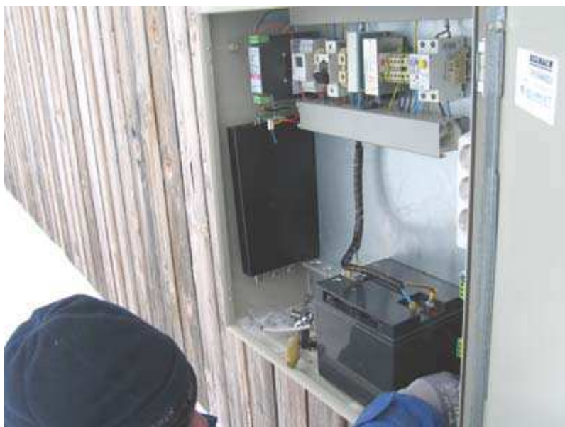
Płytki bramek z serii 600 firmy „Mikrotik“ wraz z modułami radiowymi zastosowane w bramce OE7XGX na Hintertuxer Gletscher na wysokości 3200 m n.p.m.
